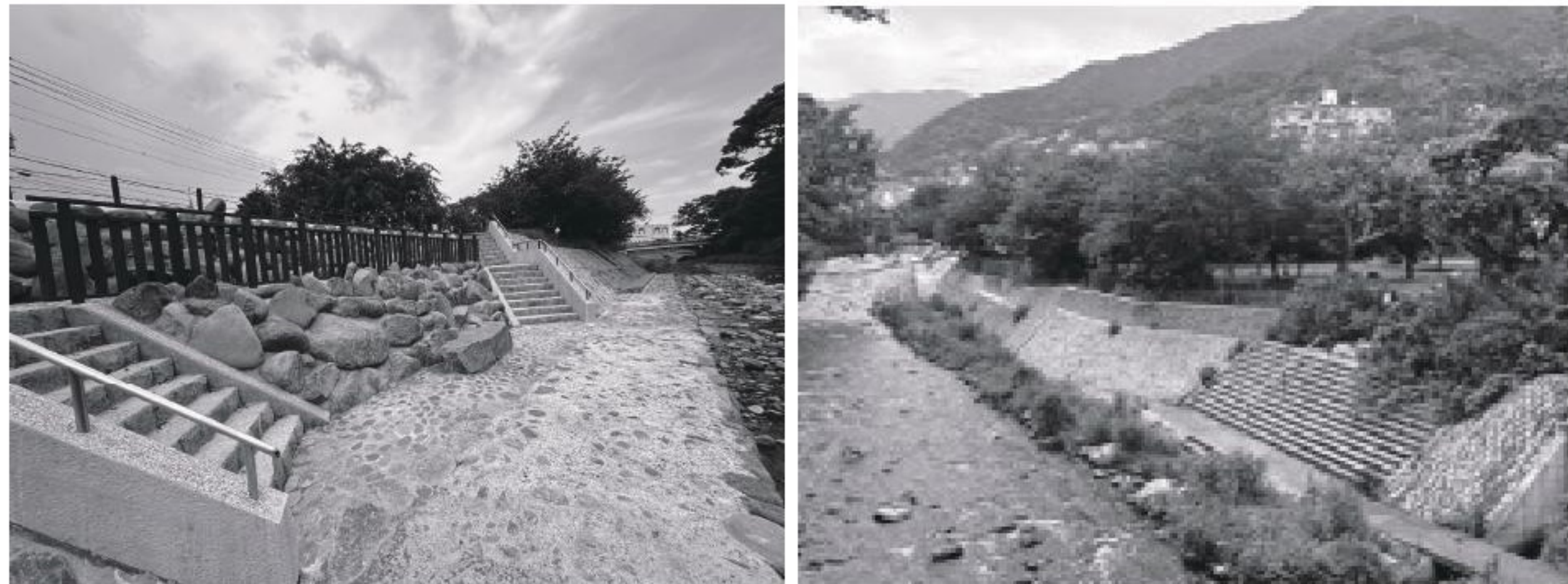
(写真) 県の護岸工事が完了した川端公園の水辺の様子 (7月下旬) 自然に囲まれたこの公園は、川のせせらぎに癒される素敵な場所です。
